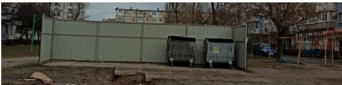
Фото. Контейнерний майданчик з твердим покриттям та огороженням
