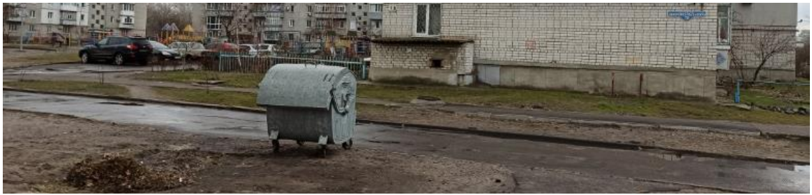
Фото. Контейнерний майданчик необлаштований
